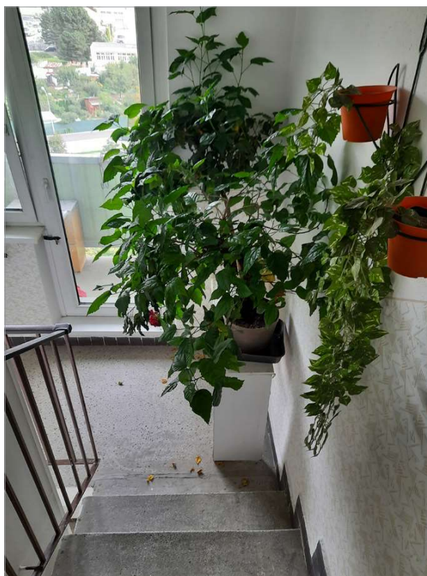
Na chodbách a schodištích nesmí být z důvodu požární bezpečnosti žádné překážky – od botníků, květin až po odložené věci
