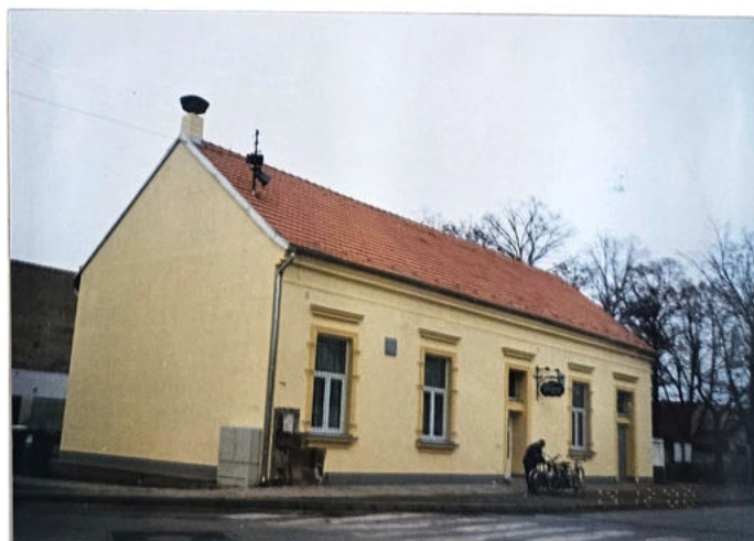
REKONSTRUKCE RESTAURACE V PRÁCHEŇICÍCH →
